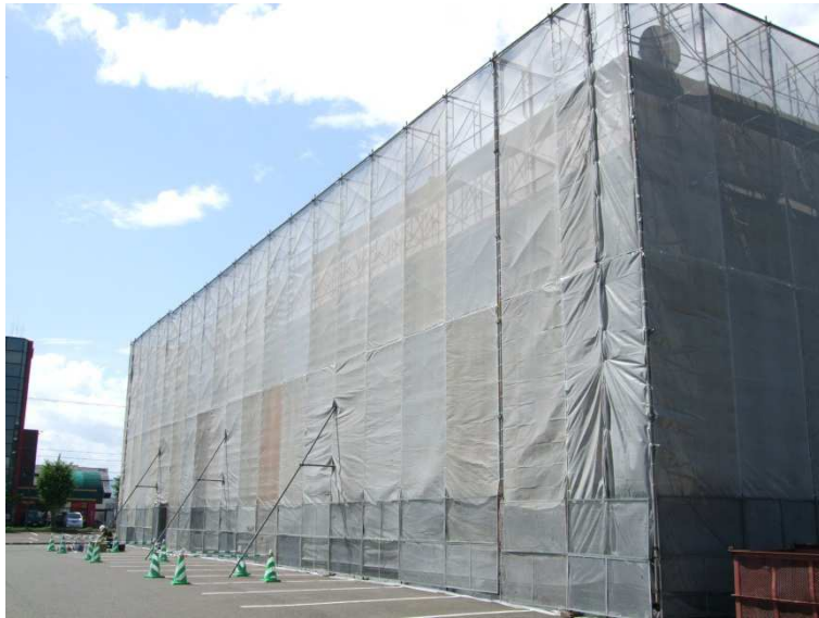
外部足場完了
