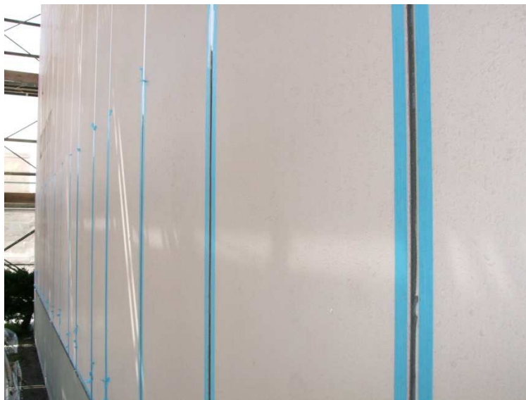
押し成形セメント板 目地 撤去後新規コーキング
